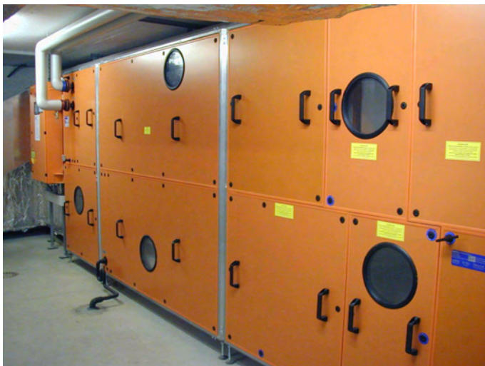
FIG. 1.17 – Gauche : monobloc de ventilation à double-flux avec double échangeur de chaleur. Débit nominal de 6'000 m 3 /h. Droite : prises d'air neuf.
