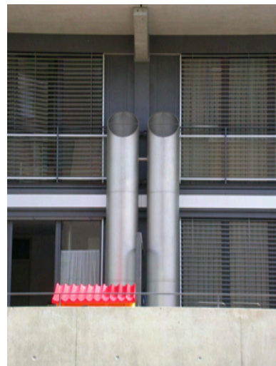
FIG. 1.17 – Gauche : monobloc de ventilation à double-flux avec double échangeur de chaleur. Débit nominal de 6'000 m 3 /h. Droite : prises d'air neuf.
