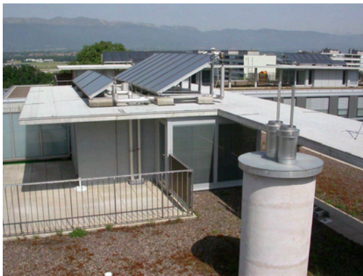
FIG. 1.16 – Installation solaire thermique de 44 m 2 en toiture du bâtiment Giacometti (seulement une moitié visible sur les photos).
