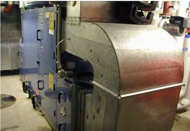
Monobloc de ventilation double-flux.
