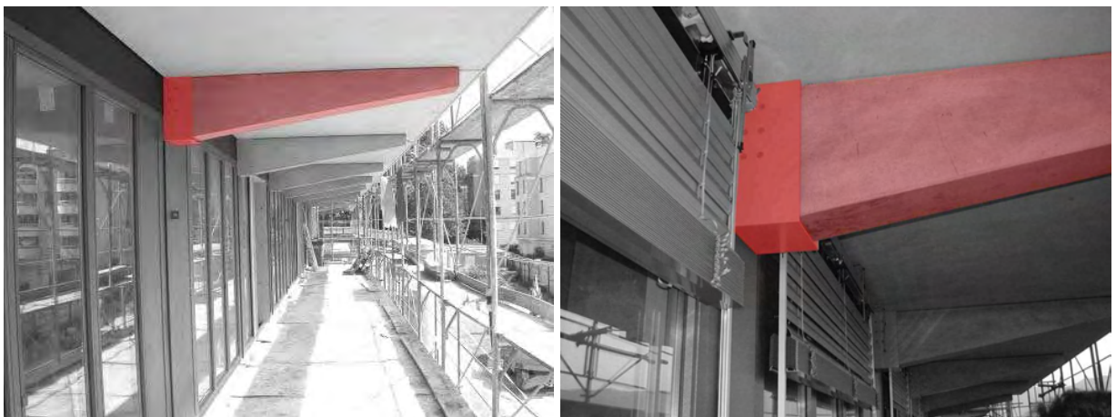
FIG. 1.10 – Consolés de support des balcons.
