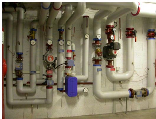
FIG. 1.14 – Gauche : les deux chaudières à gaz à condensation d'une puissance modulable de 25 à 250 kW chacune (Ygnis). Droite : distribution de chaleur en sortie des chaudières (CAD).
