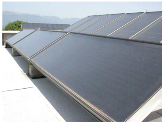
FIG. 1.16 – Installation solaire thermique de 44 m 2 en toiture du bâtiment Giacometti (seulement une moitié visible sur les photos).
