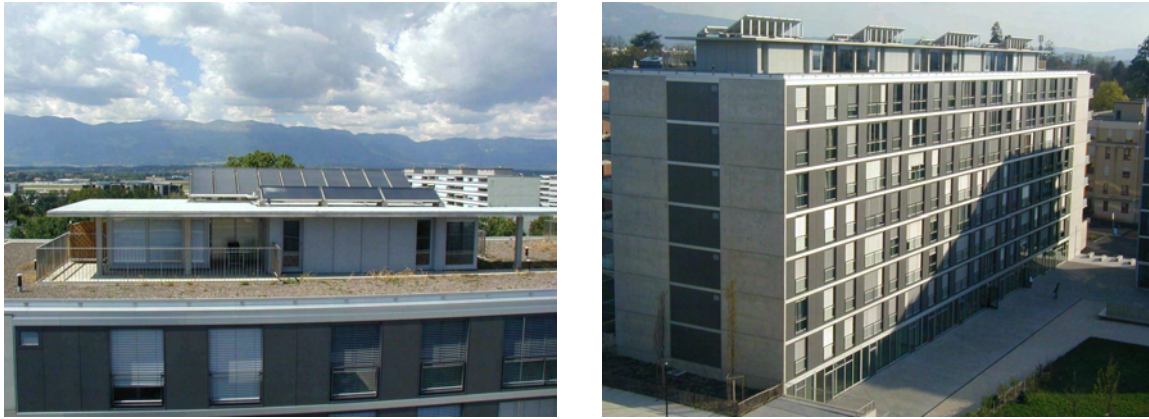
FIG. 1.3 – Gauche : duplex ; toiture végétalisée. Droite : bâtiment Gardiol, façade nord-ouest.
