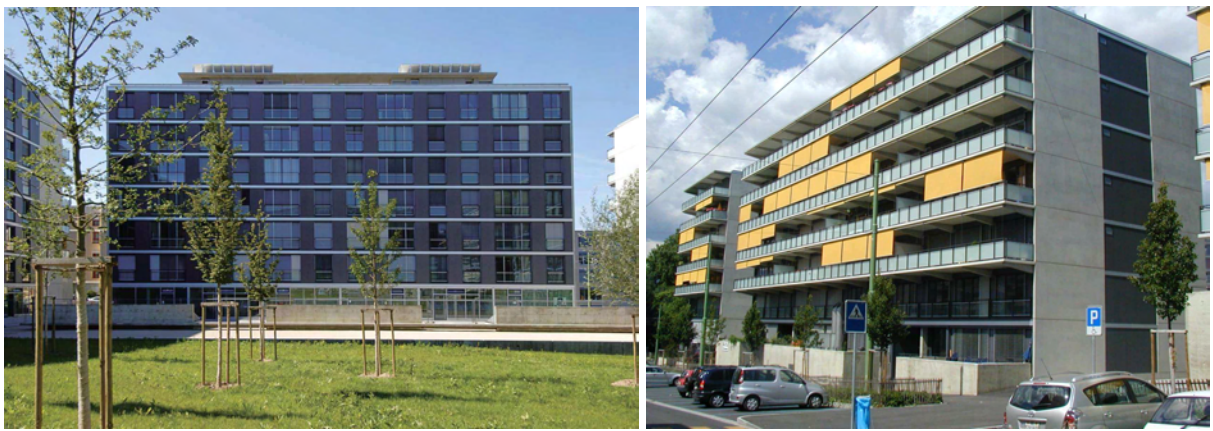
FIG. 1.2 – Façade nord-est (gauche) et sud-ouest (droite) du bâtiment central "Giacometti".
