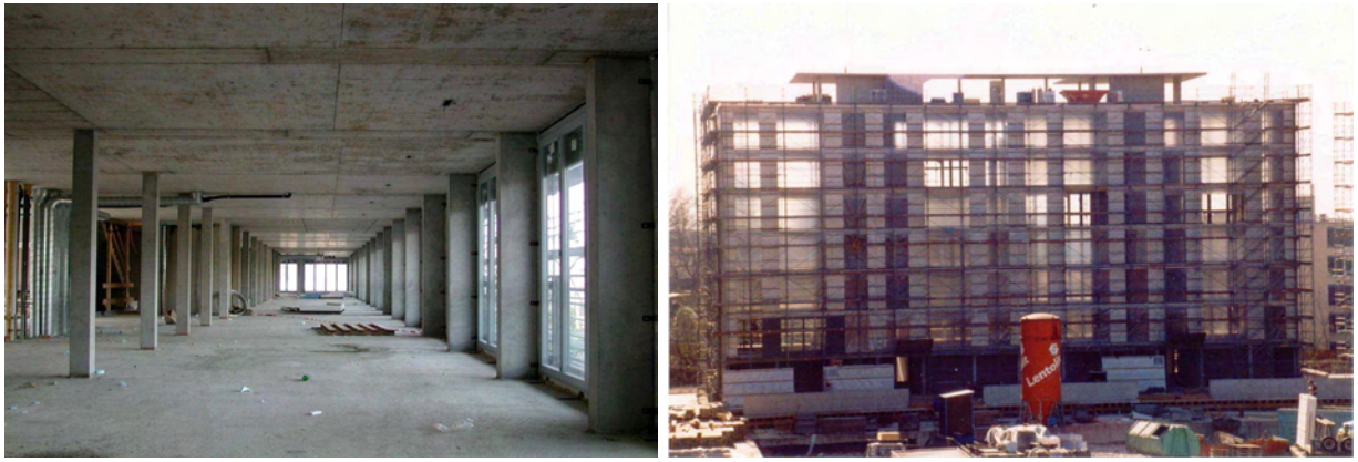
FIG. 1.7 – Structure ponctuelle des bâtiments.
