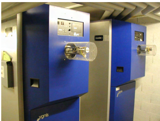
FIG. 1.14 – Gauche : les deux chaudières à gaz à condensation d'une puissance modulable de 25 à 250 kW chacune (Ygnis). Droite : distribution de chaleur en sortie des chaudières (CAD).
